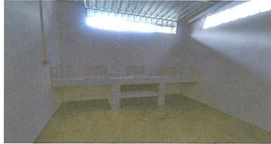
Foto 2: Finalización de levantamiento y repello de pared del interior de la cocina del establecimiento
