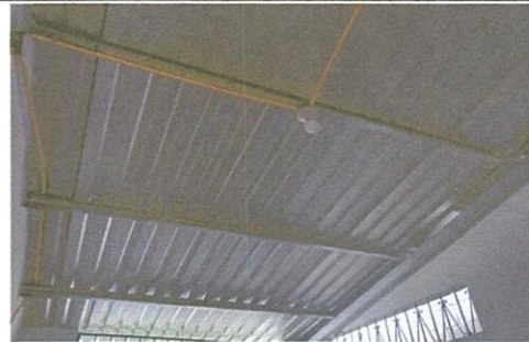
Foto 4: instalación de electricidad finalizado
