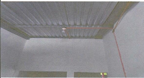
Foto 3: Techado de la cocina finalizado
