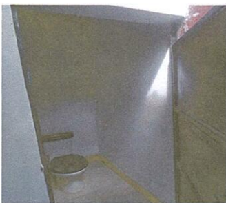
Foto 5: finalización de repello y levantamiento de pared de los sanitarios
